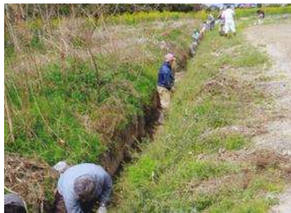
(水路の堀さらい)
